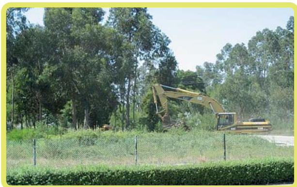
Início das obras de construção da nova unidade HyCO 3
