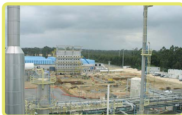
Estado actual das obras de construção da nova unidade HyCO 3
